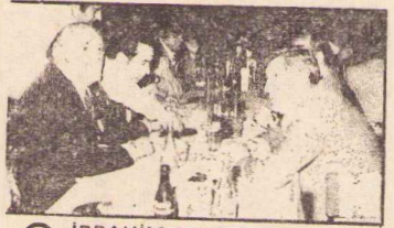
IBRAHİM BODUR: "Önce bağımsızların desteğiyle CHP iktidar olsun..."
